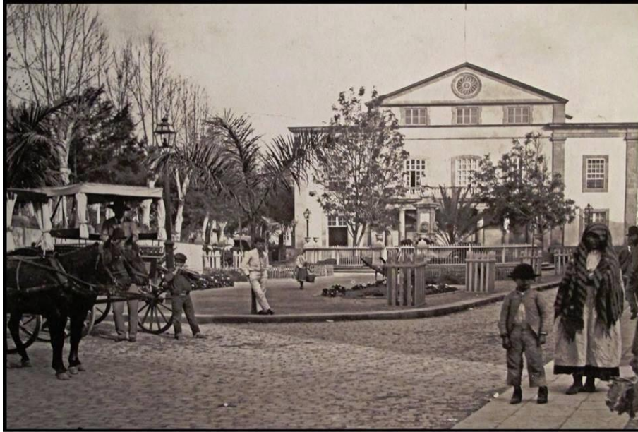
Figura 9. Teatro Cairasco. (Las Palmas de Gran Canaria). Fachada principal.
