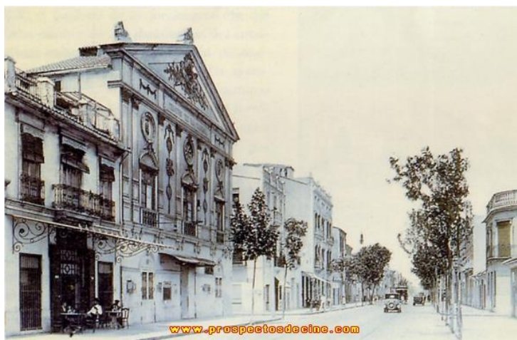
Figura 17. Teatro de La Marina del Cabañal. (Valencia). Fachada principal.
