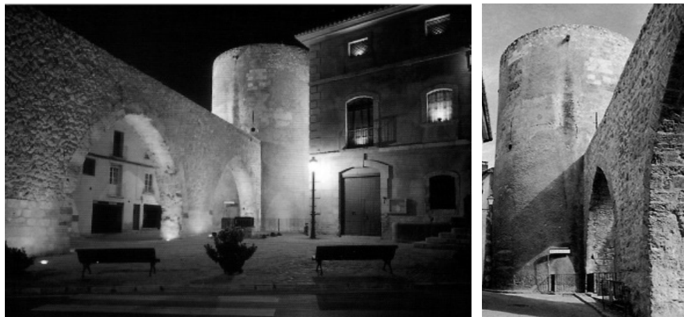
Vistas de Acueducto y Torre del Botxí o Verdugo
