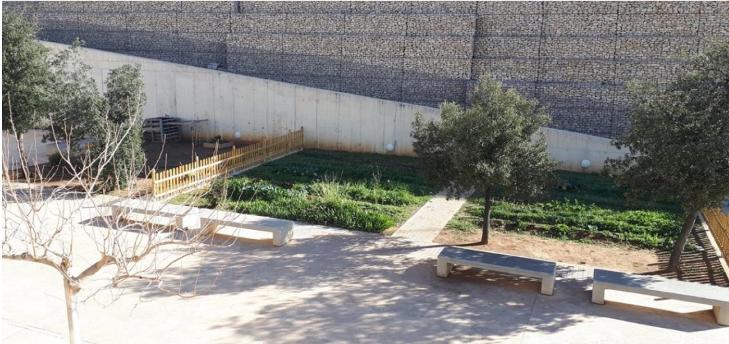
Ilustración 8 Espacio exterior: huerto escolar
