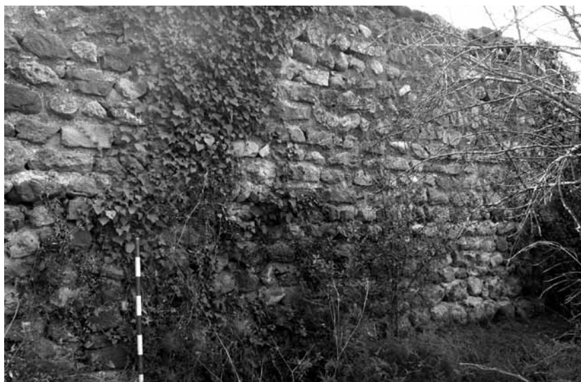
Corral de Vilambuch en Eslida. Coordenadas UTM: 732878X 4419993Y. Huso 30.
