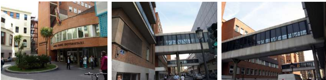
FIGURA 11. FOTOS DEL HOSPITAL CLÍNICO UNIVERSITARIO DE VALENCIA
