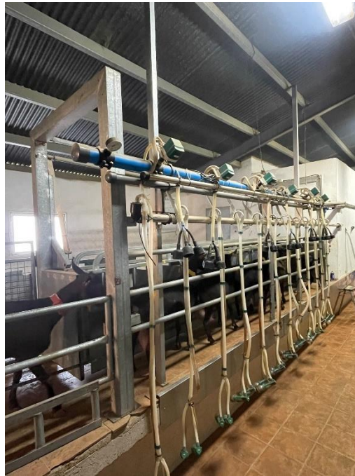
Figura 11: Sala de ordeño de la explotación C.
